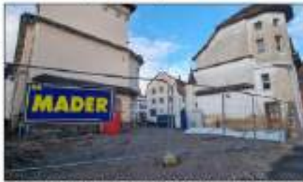
Le lieu situé à l'angle des rues Théodore-Deck et de la Commanderie est le point de départ de l'immense chantier en cours à l'Institut Saint-Joseph. (Photo : Christophe Koenig)
